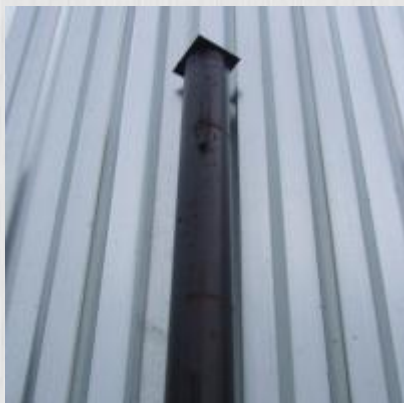
Столб грунтованный d48мм, толщ.1,5мм, длина 2,4м
